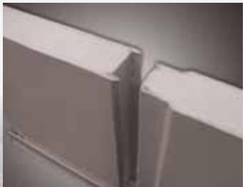
▼ Unión entre paneles de 150 o 200 mm. espumada in-situ
